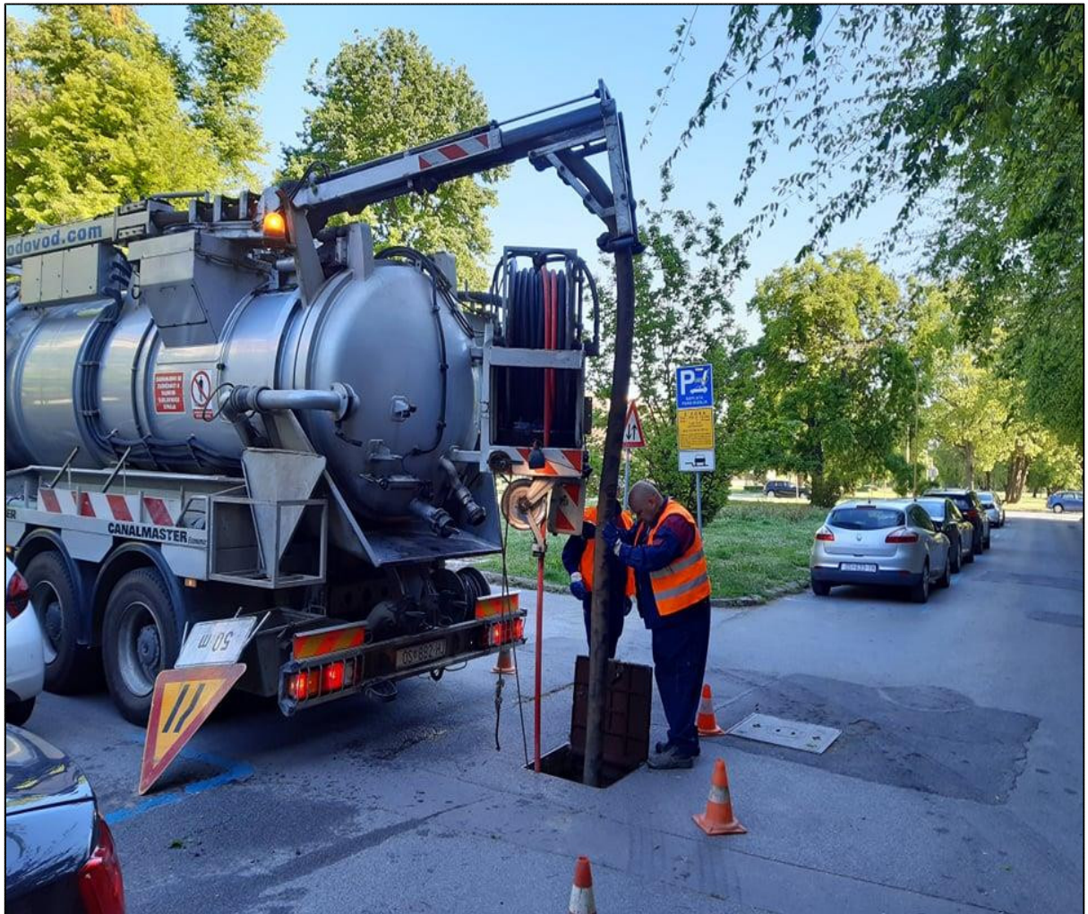
Slika 9. Ispiranje kanalizacije [7]
