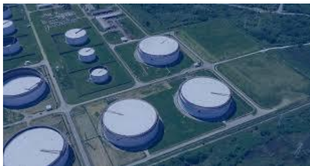
Slika 10. Rezervoar za skladištenje u Sisku
