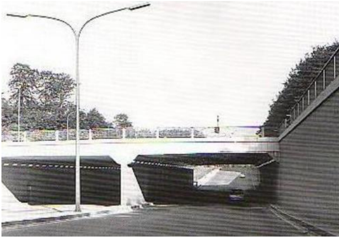
Slika 16: Primjer crnog okvira prilikom ulaska u tunel
