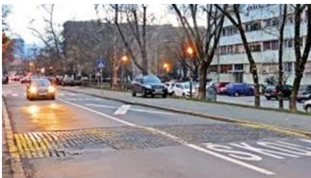
Slika 1: Smirivanje prometa - primjena kamene kocke kao kolničkog materijala
