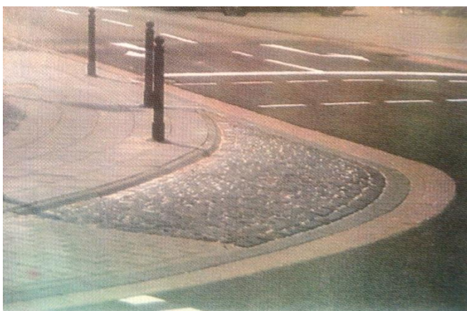
Slika 4: Rubovi raskrižja suženi i izdignuti
