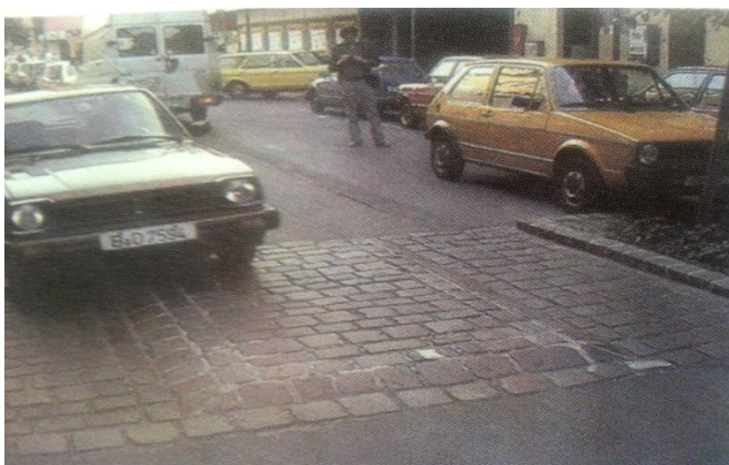
Slika 3: Suženje kolnika s vertikalnom devijacijom
