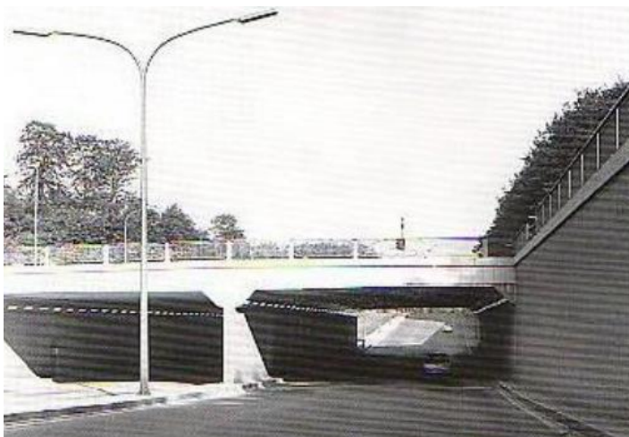
Slika 16: Primjer crnog okvira prilikom ulaska u tunel
