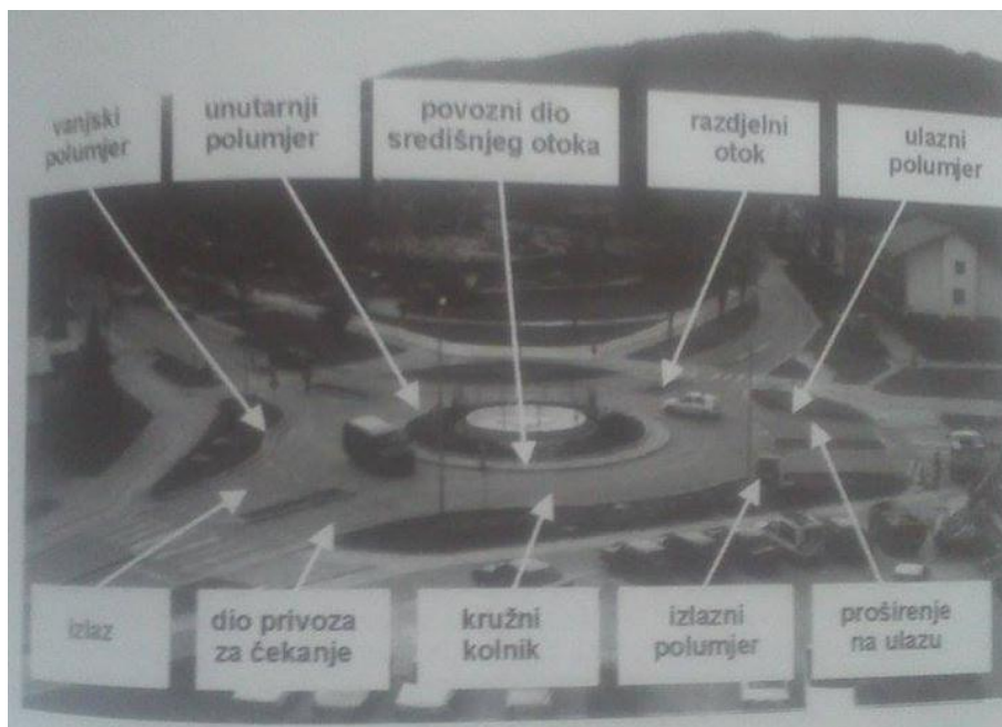
Slika 3. Dijelovi kružnog raskrižja
