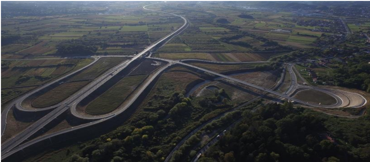
Slika 3. Brza cesta - prva dionica brze ceste Popovec – Marija Bistrica – Zabok sa spojem na Breznički Hum, dugačka 5,2 km.
