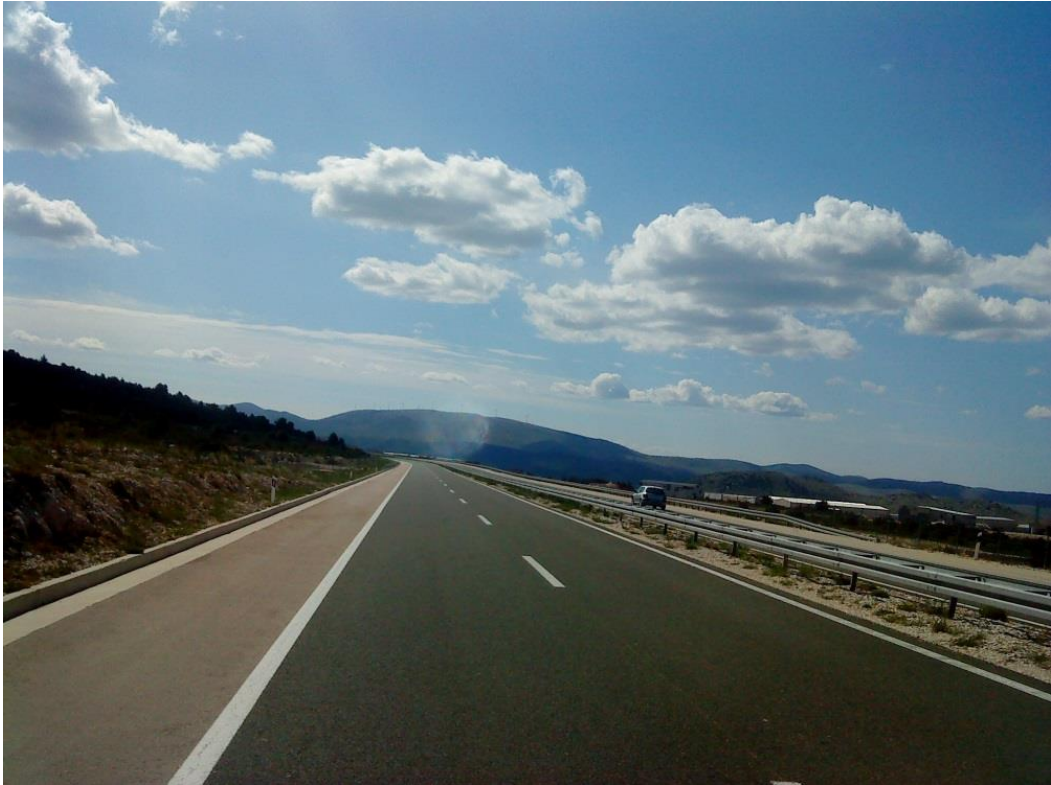
Slika 7. Trak za zaustavljanje
