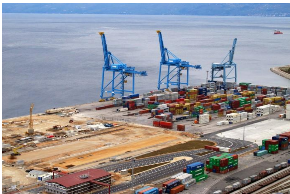
Slika 16. Manipulacijska sredstva u LO-LO tehnologiji transporta
