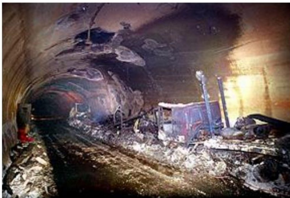
Slika 17. Požar u tunelu Mont-Blanc
