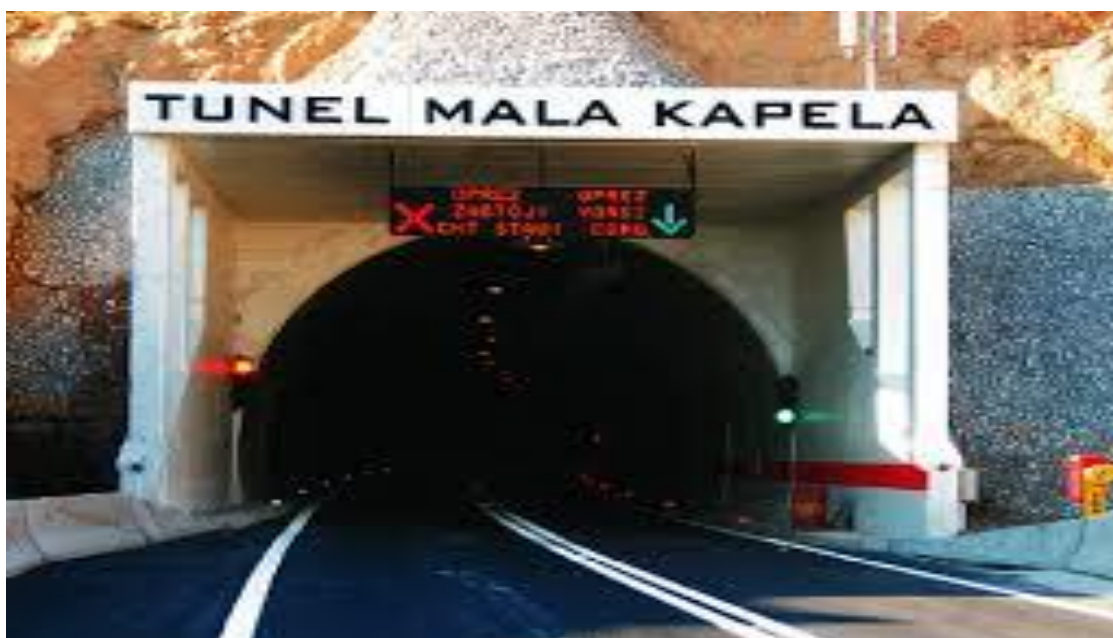
Slika 9. Tunel Mala Kapela
