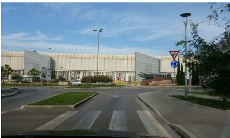
Slika 17. Kružno raskrižje ulica Domovinskog rata i S. Radića
