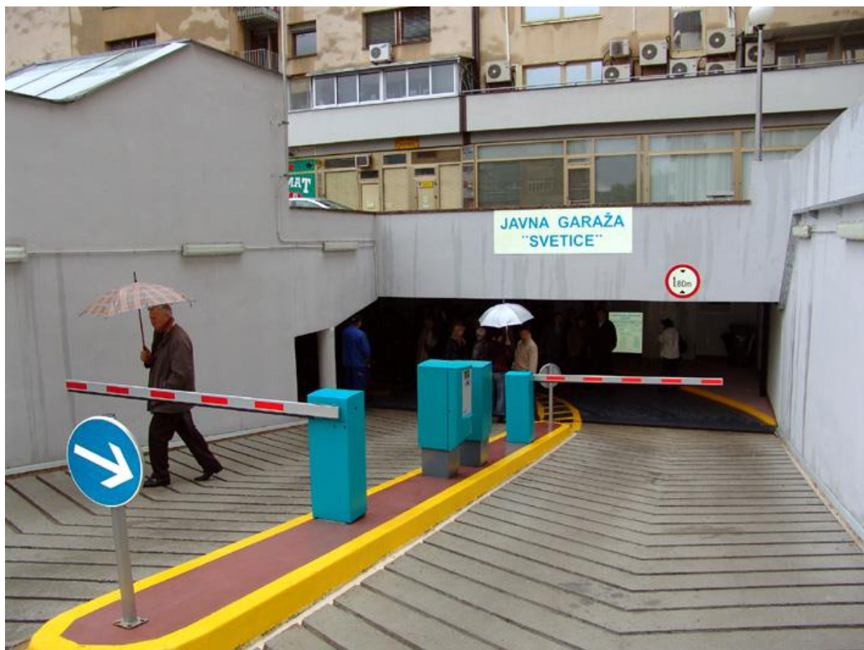
Slika 3. Garaže s rampama
