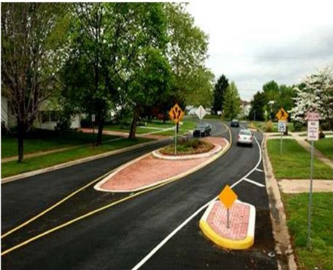
Slika 12. Primjer razdvajanja smjerova vožnje izvođenjem prometnih otoka
