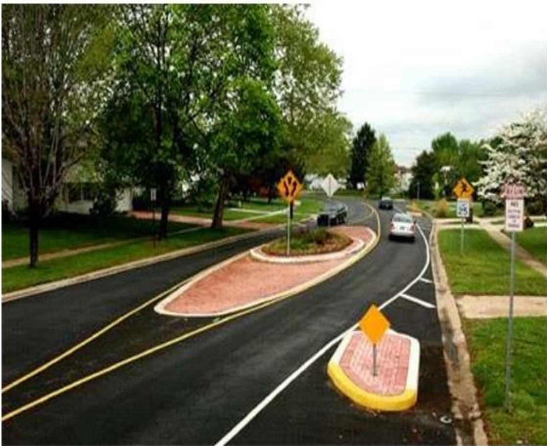
Slika 12. Primjer razdvajanja smjerova vožnje izvođenjem prometnih otoka
