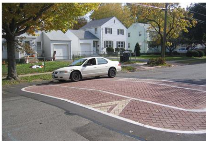
Slika 14. Izdignuće na kolniku izvedeno kombinacijom asfalta i betonskih elemenata
