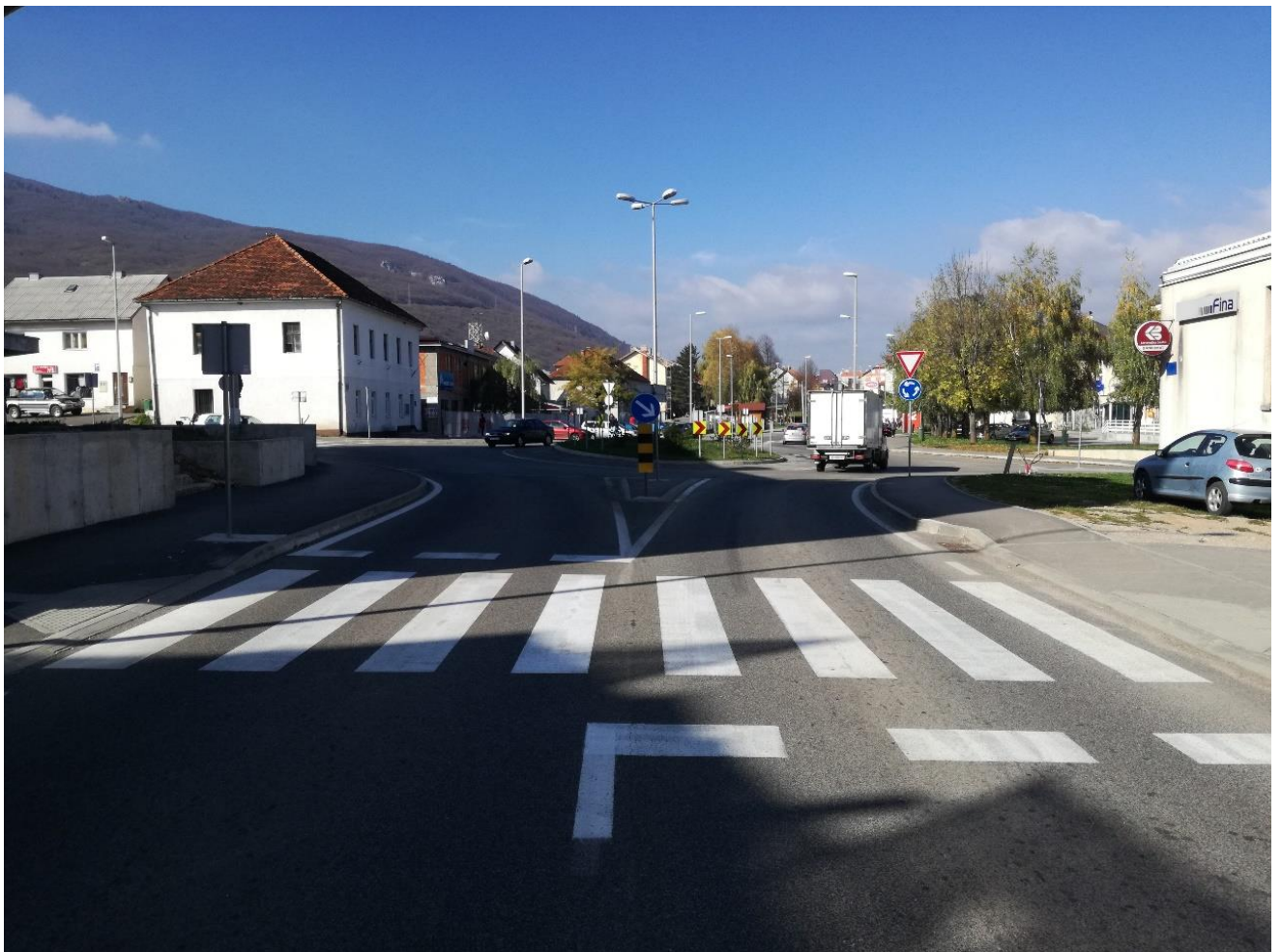
Slika 8 : Raskrižje poslije rekonstrukcije iz smjera Udbine
