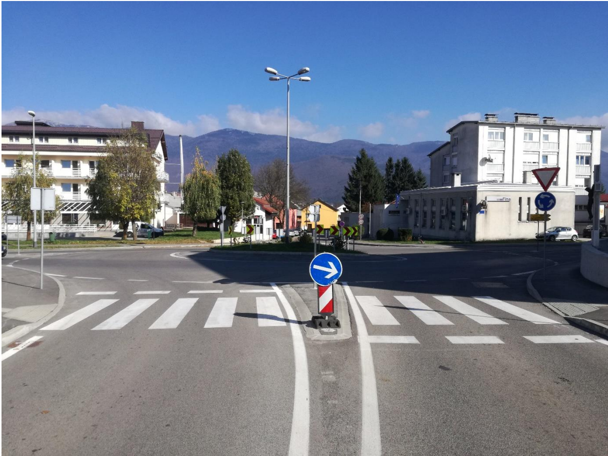
Slika 11 : Raskrižje nakon rekonstrukcije iz smjera Gospića
