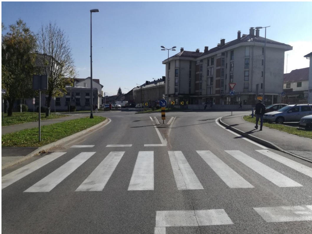
Slika 10 : Raskrižje nakon rekonstrukcije iz smjera P.Jezera
