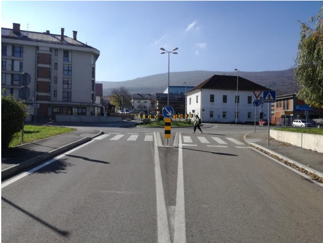
Slika 9 : Raskrižje nakon rekonstrukcije iz smjera Korenice
