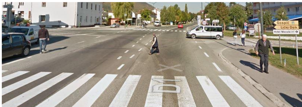
Slika 3 : Raskrižje prije rekonstrukcije iz smjera Udbine
