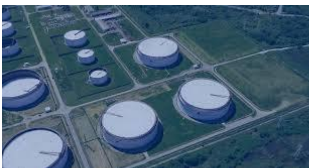
Slika 10. Rezervoar za skladištenje u Sisku
