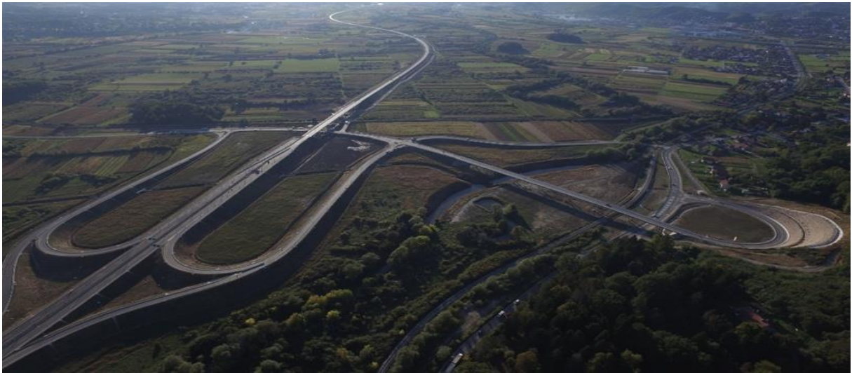
Slika 3. Brza cesta - prva dionica brze ceste Popovec – Marija Bistrica – Zabok sa spojem na Breznički Hum, dugačka 5,2 km.
