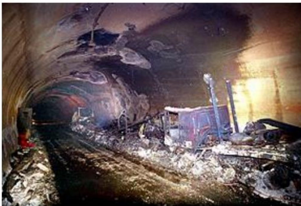
Slika 17. Požar u tunelu Mont-Blanc
