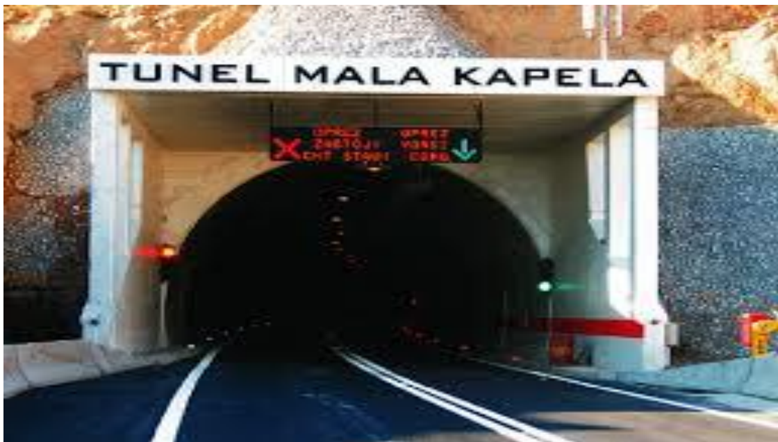
Slika 9. Tunel Mala Kapela
