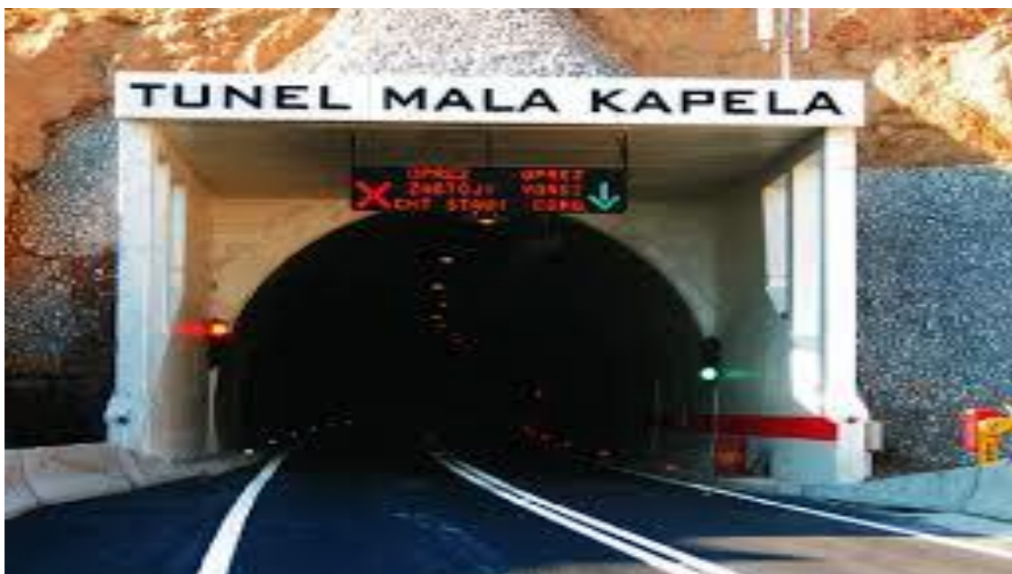
Slika 9. Tunel Mala Kapela
