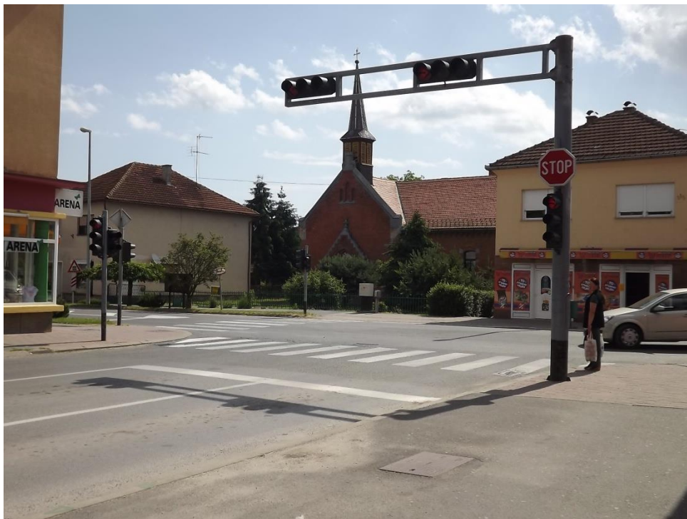
Slika 5. Raskrižje Trga Ruđera Boškovića i Ulice Vladimira Nazora
