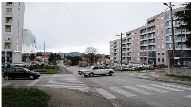
Slika 15. Raskrižje ulica Domovinskog rata, B. Benkovića i N. Tesle prije izgradnje raskrižja sa kružnim tokom
