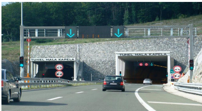
Slika 3. Tunel Mala Kapela
