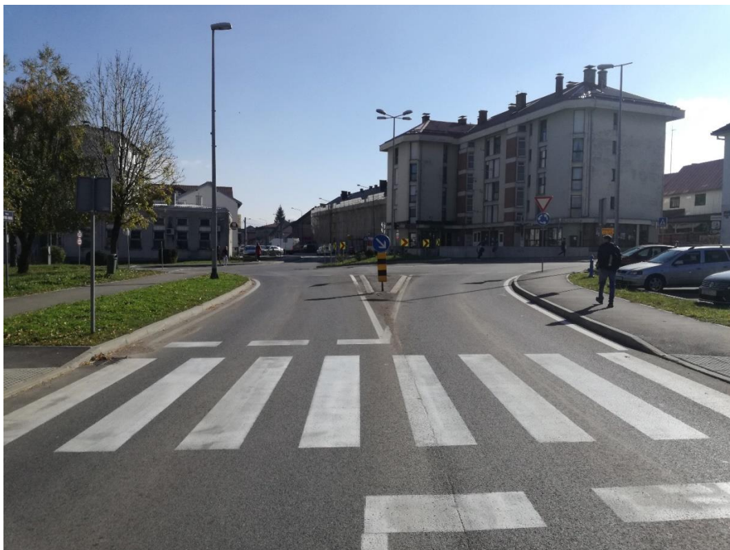
Slika 10 : Raskrižje nakon rekonstrukcije iz smjera P.Jezera
