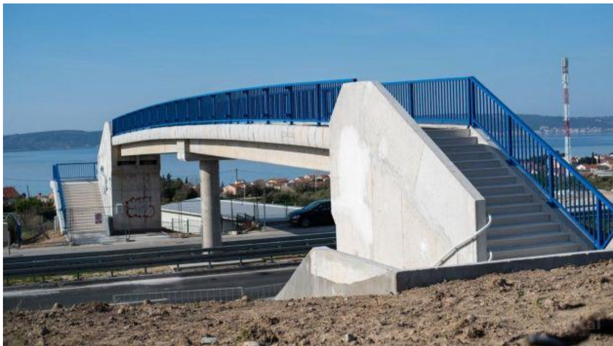
Slika 11. Primjer pješačkog nadhodnika
