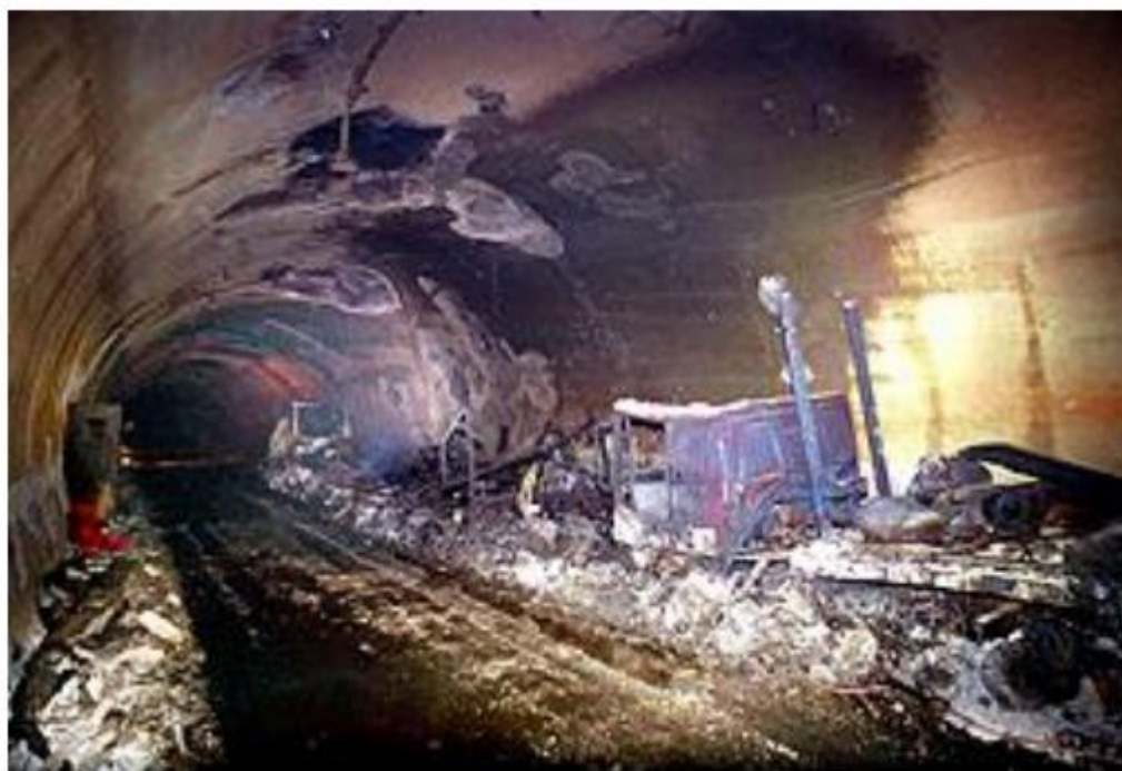
Slika 17. Požar u tunelu Mont-Blanc
