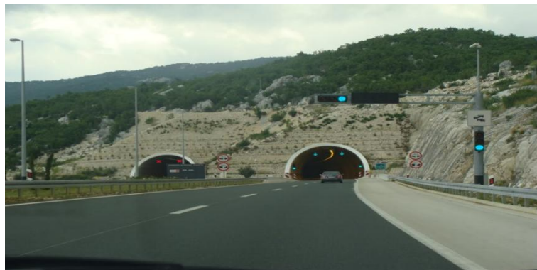
Slika 17. Tunel Crna brda
