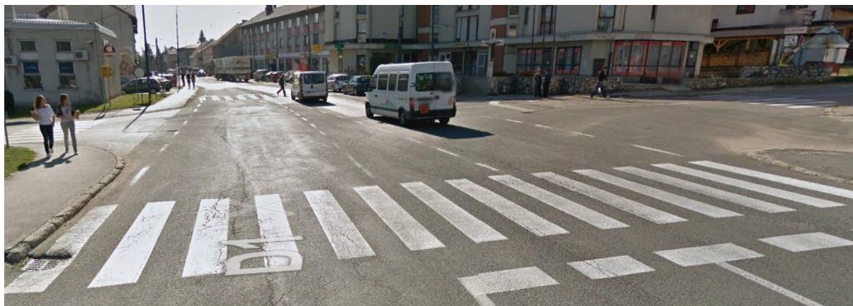
Slika 5 : Raskrižje prije rekonstrukcije iz smjera P.Jezera
