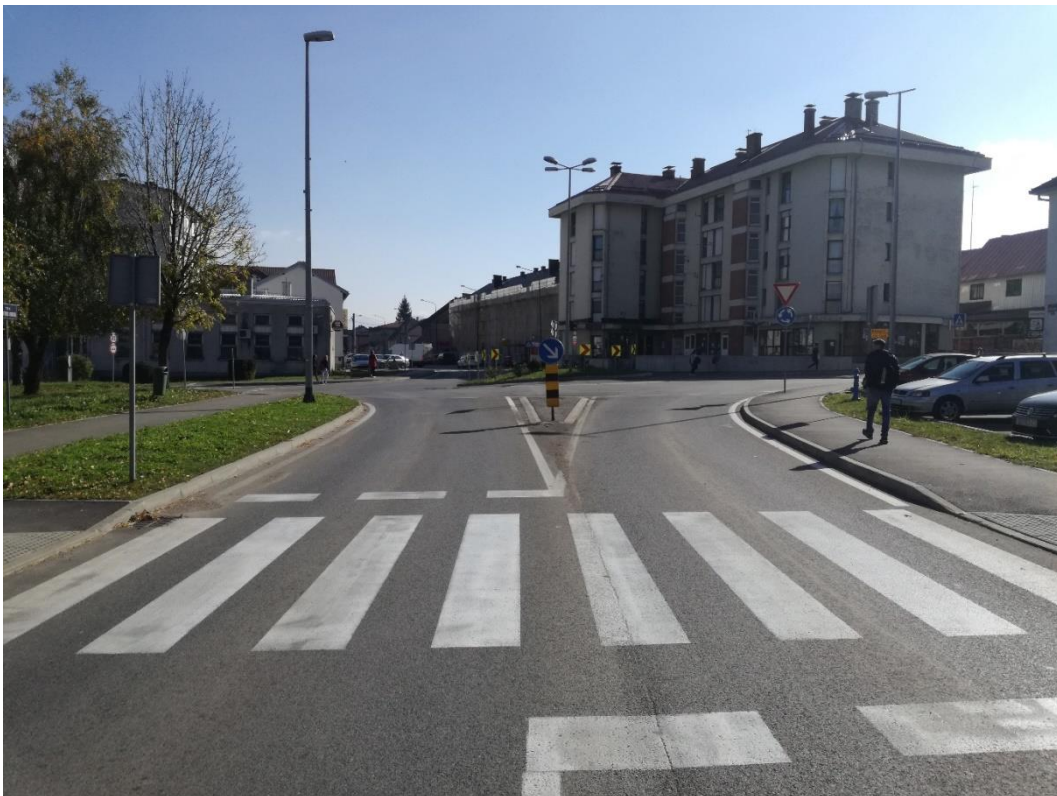
Slika 10 : Raskrižje nakon rekonstrukcije iz smjera P.Jezera
