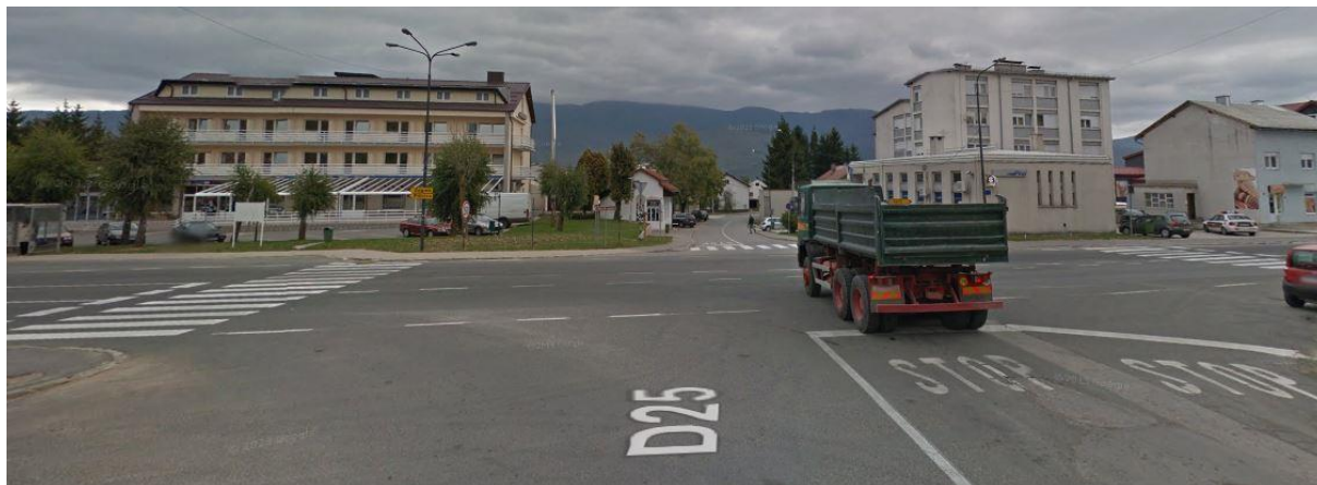
Slika 6 : Raskrižje prije rekonstrukcije iz smjera Gospića
