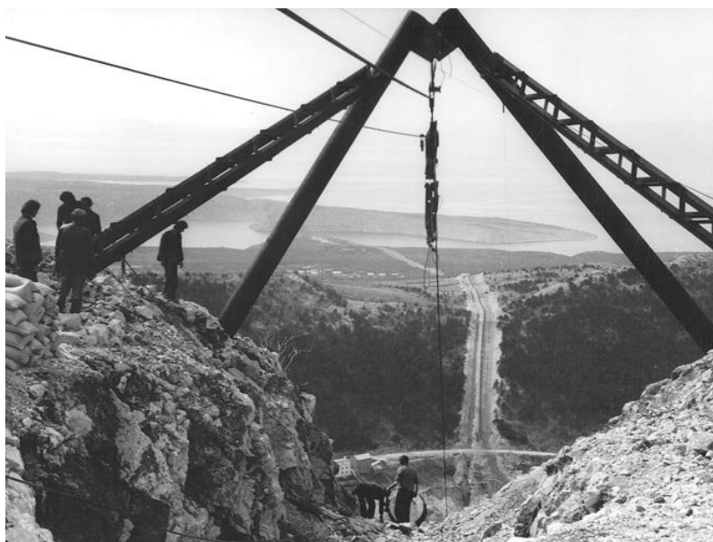
Slika 2 Izgradnja trase naftovoda Omišalj-Sisak
